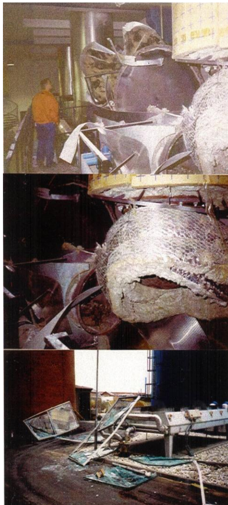
Billet viser en sprængning af rørsystem
